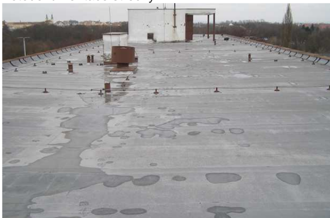
Obr. 15: Pohled na střechu A1, kaluže vody na povrchu.
