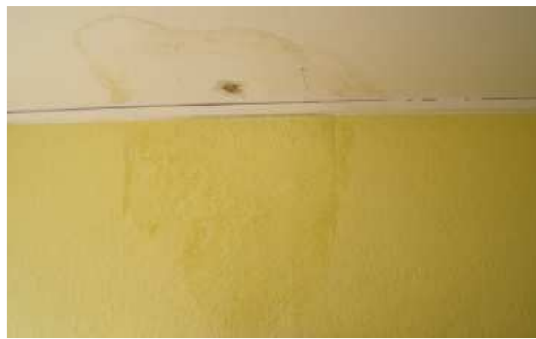
Obr. 22: Zatékání skrz střechu u budovy A1, stopy po zatékání jsou na stropu a na stěnách - místnosti pod střechou.
