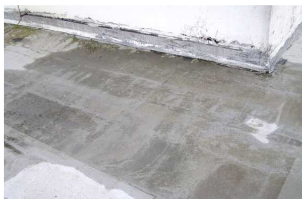
Obr. 18: Kaluže vody za strojovnou výtahu; A1.
