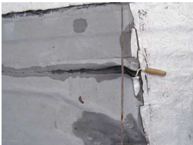
Obr. 6: Porucha dalšího přesahu vrchní fólie.
