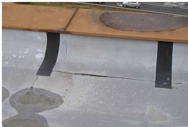
Obr. 16: Atika, poruchy spoje fólie, pásky na svislých spojích, voda na oplechování atiky, střecha A1.
