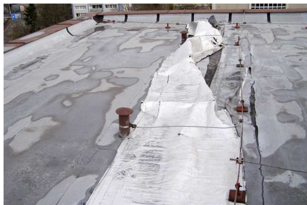
Obr. 3: Severní oblast střechy budovy A3, porucha, odtržený asfaltový pás, trhliny, nefunkční oprava.
