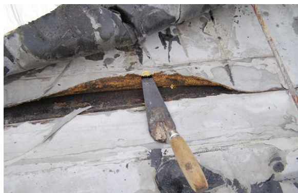
Obr. 5: Podrobnost z obr. 4, porucha přesahu fólie.
