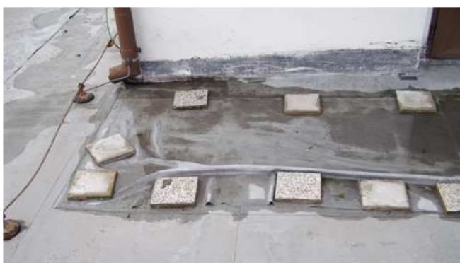
Obr. 17: Vrchní fólie je odtržená, poruchy spojů. Oblast u strojovny výtahu, střecha A1.
