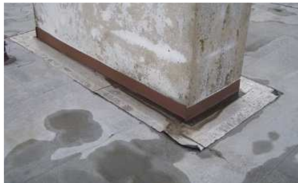
Obr. 20: Poruchy spojů fólie u komínu, střecha A1.
