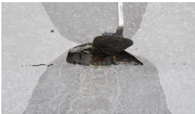
Obr. 21: Střecha A1, trhlina skrz vrchní hydroizolace a tepelnou izolaci z MW - 100 mm, sonda.
