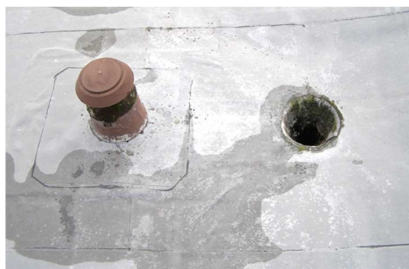
Obr. 9: Netěsnosti u vpusti, v přesazích fólie.
