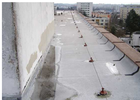
Obr. 11: Kaluže vody za strojovnou výtahu, A3.
