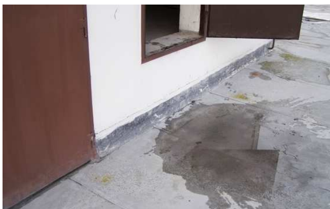
Obr. 10: Prohlubně, kaluže vody u strojovny výtahu, A3.
