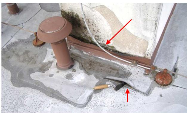
Obr. 8: Poruchy přesahů fólie, zatékání za lištami
