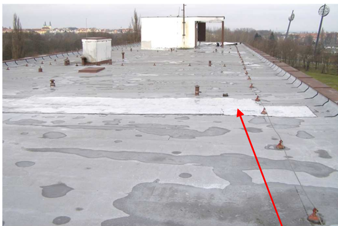
Obr. 2: Pohled na plochou střechu A3, lokální opravy
