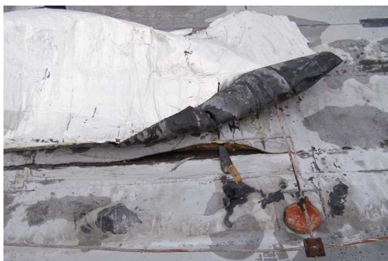
Obr. 4: Střecha A3, porucha spoje vrchní pryžové fólie.
