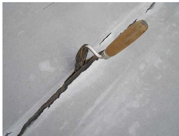
Obr. 7: Trhlina skrz vrchní hydroizolace (fólie a asf. pás) a tepelnou izolaci z MW - 100 mm, sonda.
