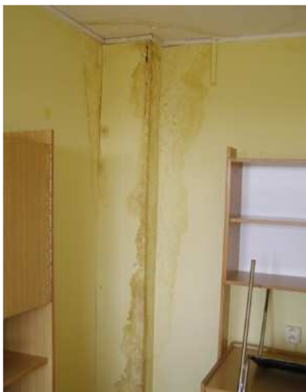
<- Obr. 23: Zatékání v okolí vpusti, a podél dešťového svodu.
