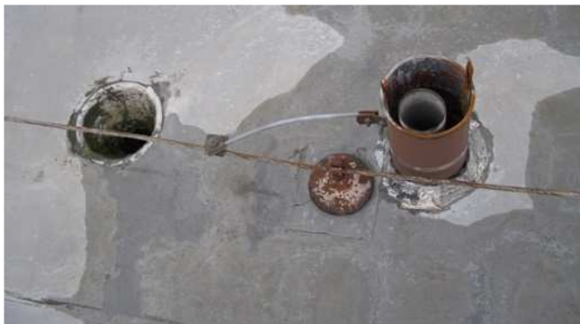
Obr. 19: Vpusť a prostup, místa zatékání, střecha A1.
