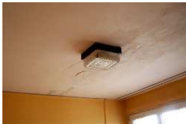
Obr. 24: Zatékání skrz střechu budovy A1, stopy po zatékání jsou na stropu a na stěnách v místnosti pod střechem.
